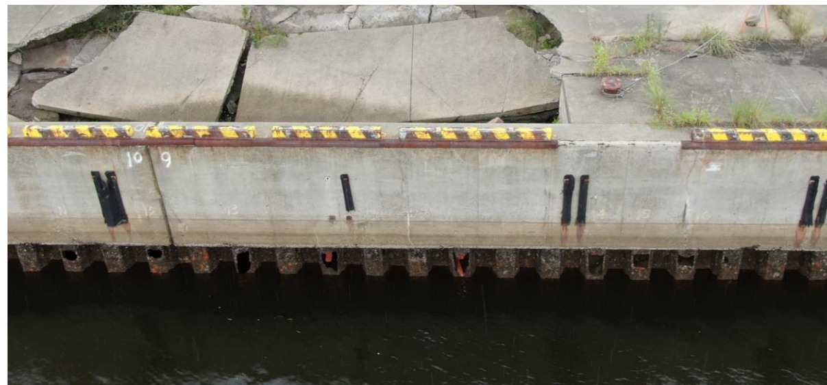
ドローンで空撮した港湾岸壁
